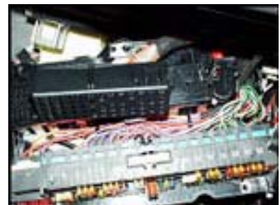
Ausbau Relaiskasten, Kammverbinder
